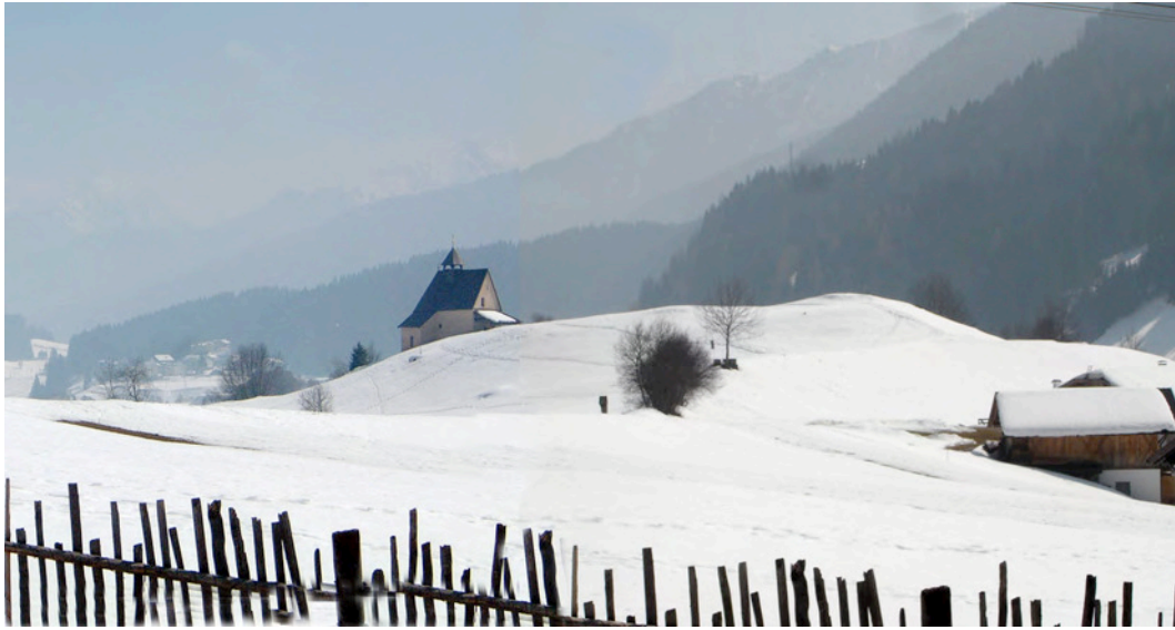
Lorenzikirche Nordansicht – Vista da Nord
